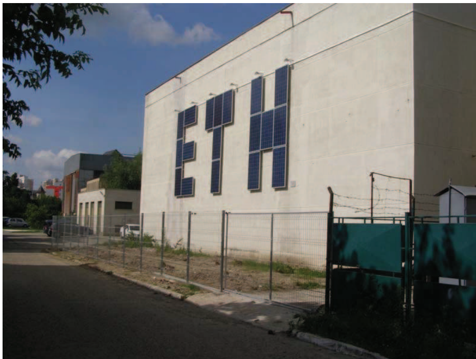
Fig. 2. Sistemul instalat de panouri fotovoltaice
